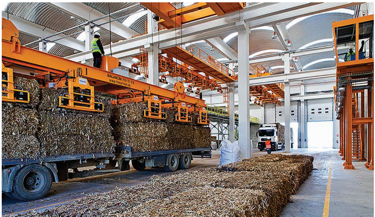
FIGURE 21: Balles de résidus de maïs dans l'installation de stockage de la biomasse de la centrale électrique de Miajadas 55
