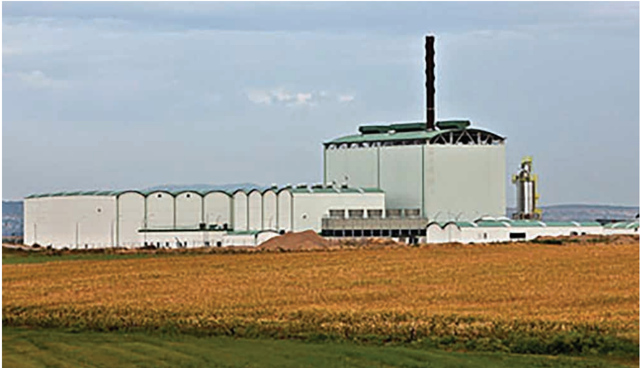
FIGURE 20: Miajadas - Centrale Biomasse 15 MW
