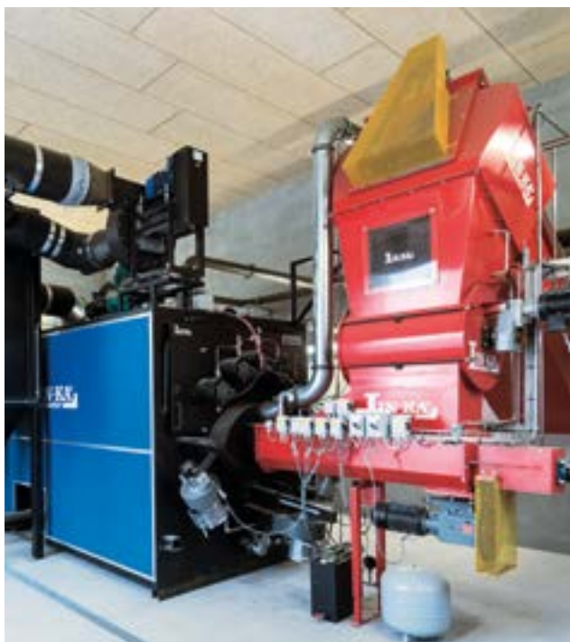
Planta automática de 800 kW de Linka Energy. FOTO Linka Energy.
