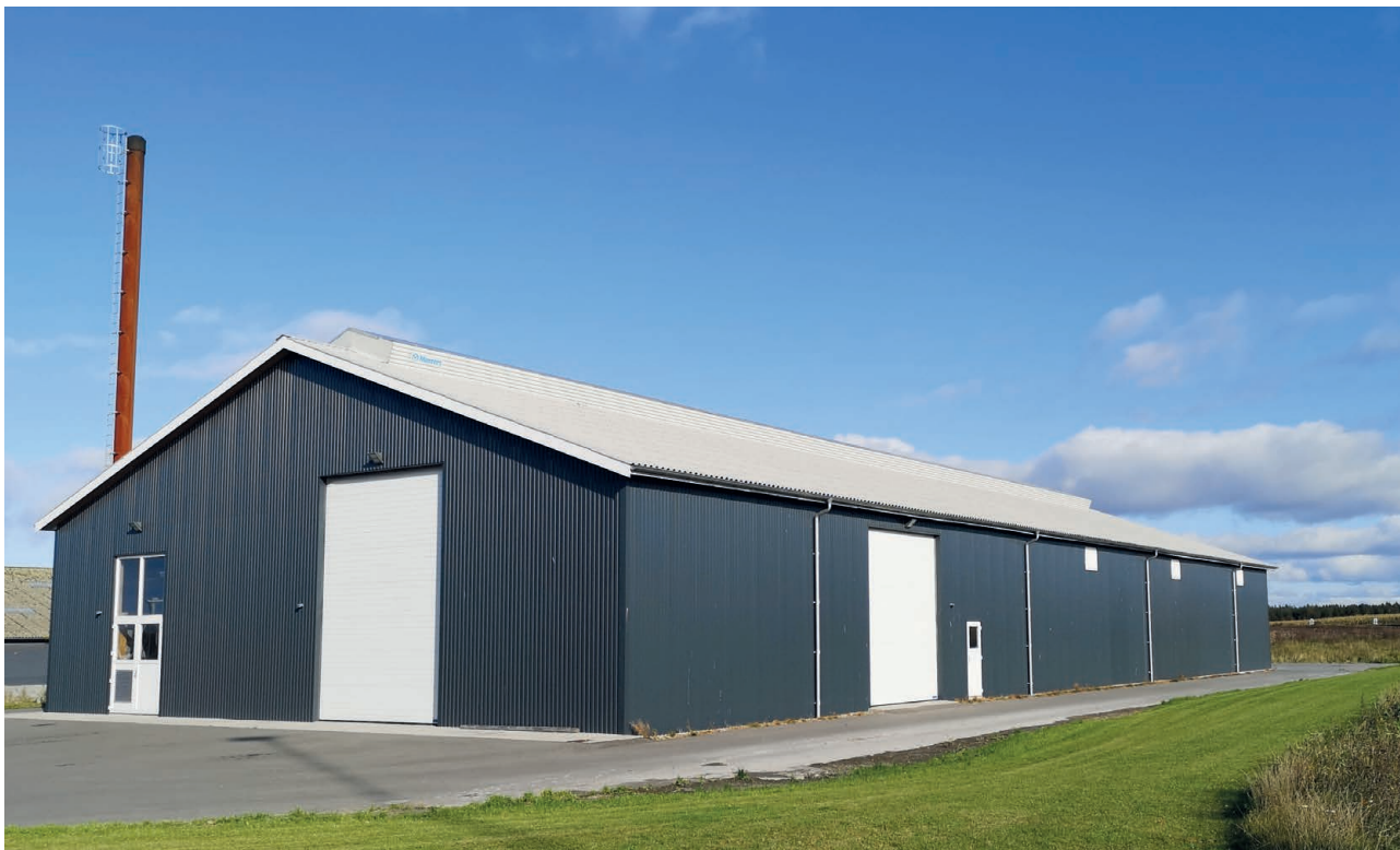
Από τη δεκαετία του '80, πραγματοποιήθηκε αποκέντρωση της παραγωγής ενέργειας στη Δανία και σήμερα πολλές μικρότερες μονάδες παράγουν ηλεκτρική ενέργεια και ενσωματώνονται σε δίκτυα τηλεθέρμανσης. ΦΩΤΟΓΡΑΦΙΑ Kirsten Krogh.
