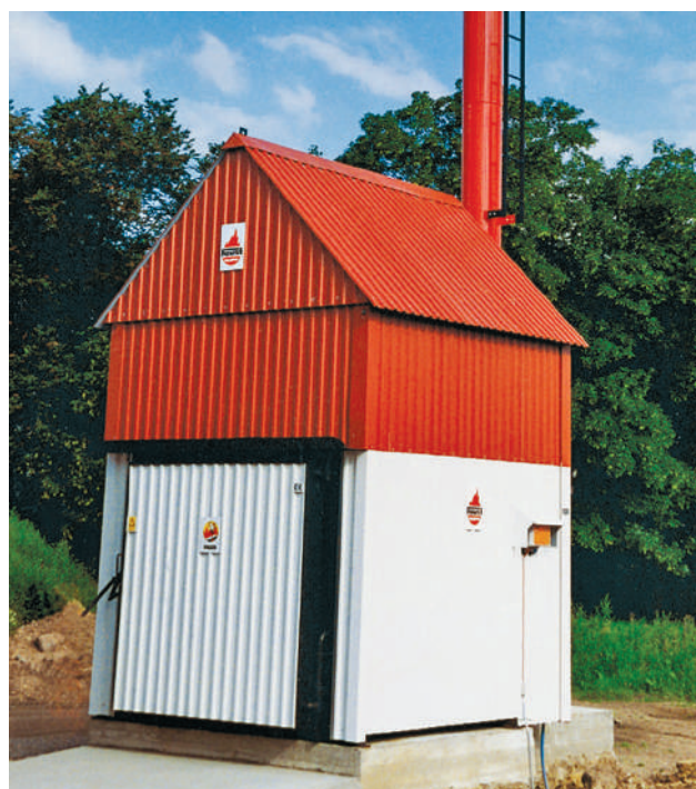
Porcionalna postrojenja često se ugrađuju u zasebnu zgradu kako bi se smanjio rizik od požara. SLIKA Torben Skøtt, BioPress.
