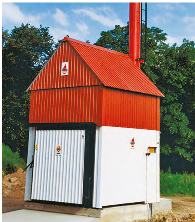
Centralele porționate sunt adesea instalate într-o clădire separată pentru a reduce riscurile de incendiu. Fotografie Torben Skøtt, BioPress.
