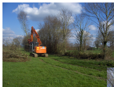
Marquage des arbres et abattage mécanisé à la pelle équipée d'une pince sécateur
